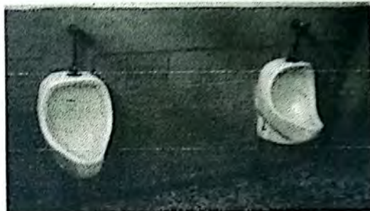
Foto 2: Mingitorios con accesorios inservibles modulo 2
